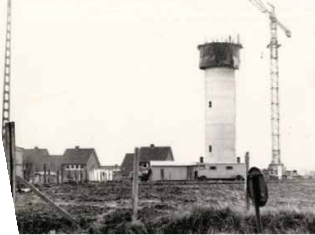
bouw watertoren Poperinge (Het Wekelijks Nieuws, 2-02-1973, p.7)
